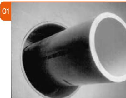
Отцентрируйте трубу в заранее просверленном стеновом отверстии или в гильзе. Убедитесь, что трубопровод имеет опору с обеих сторон. Уплотнительная цепь не должна выдерживать вес трубы.
