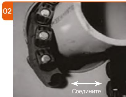
Ослабьте заднюю прижимную пластину с помощью гайки ровно настолько, чтобы звенья двигались свободно друг к другу и друг от друга. Соедините оба конца цепного уплотнения.
