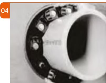
Убедитесь, что прижимные пластины на обратной стороне цепи уплотнения выровнены правильно. После установки в проем в стене они больше не будут доступны. Вставьте уплотнительную цепь в кольцевое пространство. Для цепи с уплотнением большего размера начните вставлять узел цепи в положение на «6 часов» и двигайте обе стороны вверх к положению на «12 часов» в кольцевом пространстве.
