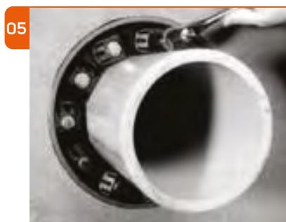
Начните с положения на «12 часов». Поочередно затягивайте все болты по часовой стрелке. Затягивайте только вручную. Не затягивайте крест-накрест. Продолжайте затягивать для равномерного сжатия.
